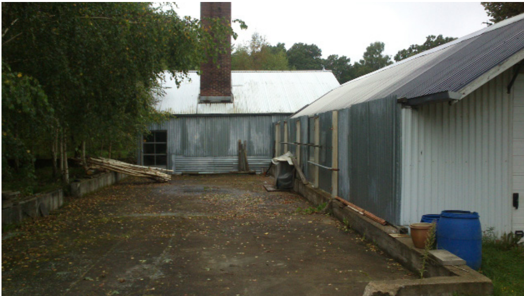
Fotografiet är taget från samma plats som föregående foto men mot väst. Byggnaderna i korrigerad plåt är från den tidigare odlings- och handelsträdgårdsverksamheten men står idag helt obrukade och underhålls inte.
